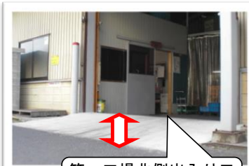
第一工場北側出入り口 地面から150mmかさ上げ
