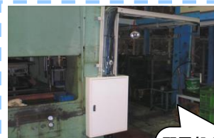
配電盤からの配線を地上配線にしてケーブル中継BOXをプレス機に取り付けた
