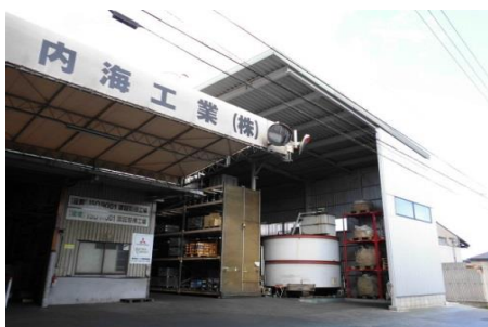
めっきライン新設に伴い 第2工場の屋根も増設しラックも購入
